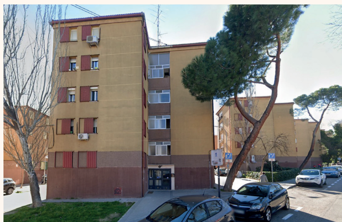
Calle de los Aparejadores, Gran San Blas, Madrid, en la actualidad.
