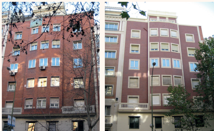
Figura 3. Obra de rehabilitación en la calle Velázquez de Jesús García Merchán, Madrid.
