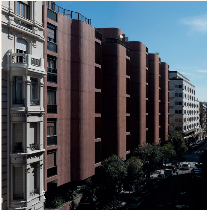
Figura 1. Coderch y Valls, Edificio Girasol. Madrid (1966). Rehabilitación de José Javier Galante Terror (2013-2019). ©Carlos de Miguel Moreno.
